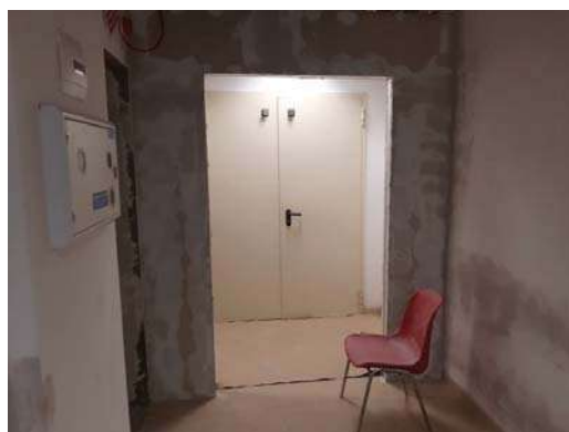
Figura 2 realizzazione filtri e nuove compartimentazioni (rei)
