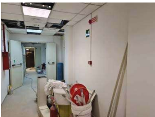
Figura 3 rinnovo delle controsoffittature nel percorso sporco
