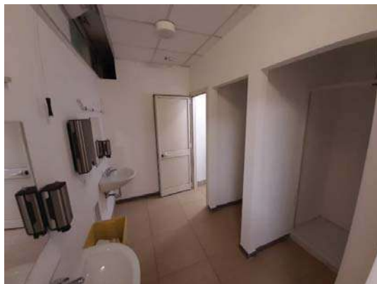
Figura 5 realizzazione nuovi bagni e docce
