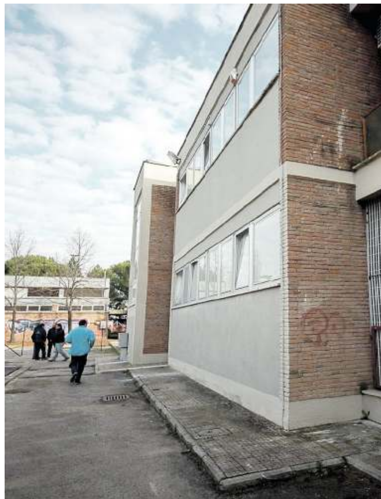
CENTRALE La sede del 118 di Latina
