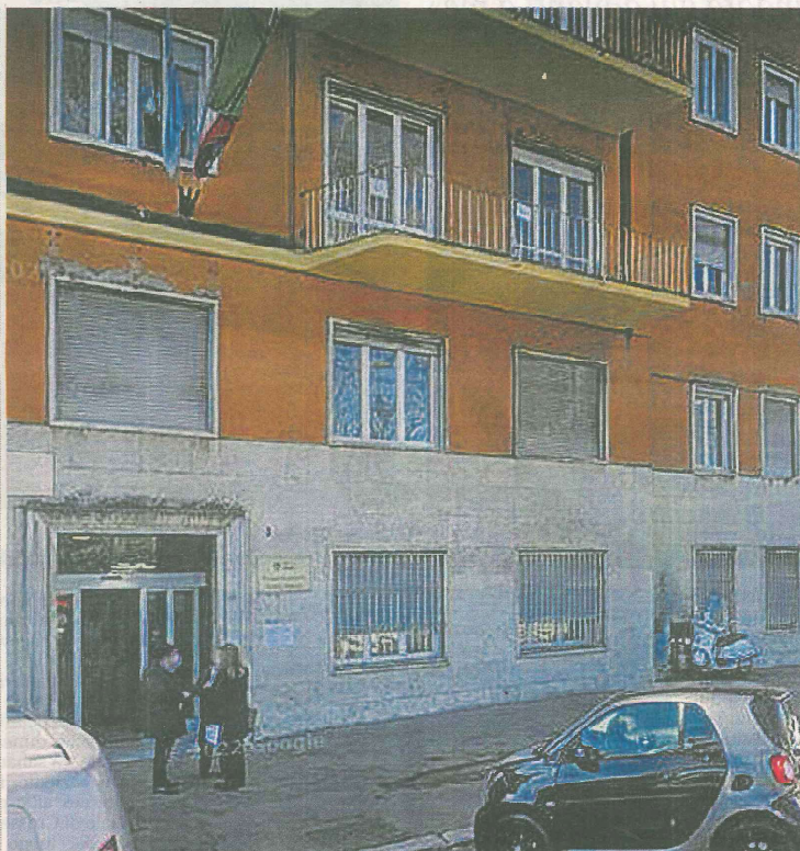
Lungotevere della Vittoria L'ingresso dell'Asl Rm1
